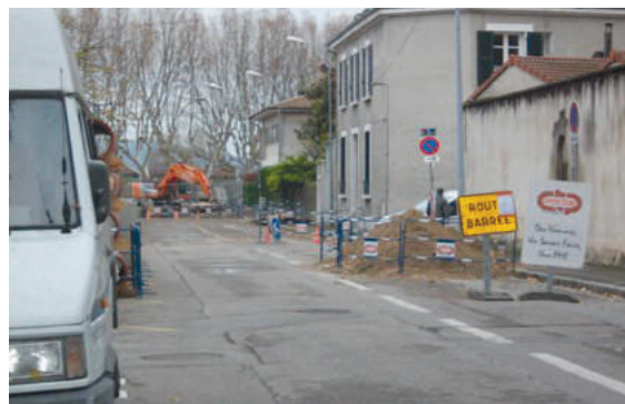
Rue en chantier
