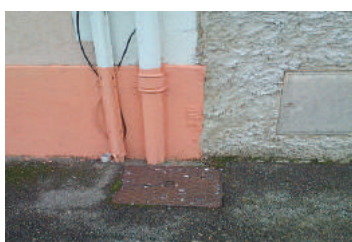
Boîte de branchement - Source : ATTF
