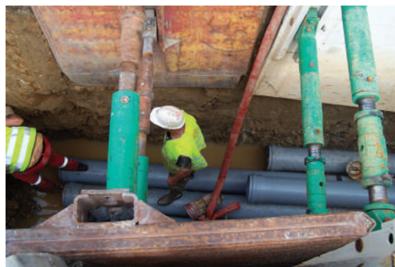
Pose de réseau
