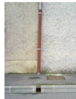
Descente de toiture et extrémité de gargouille
