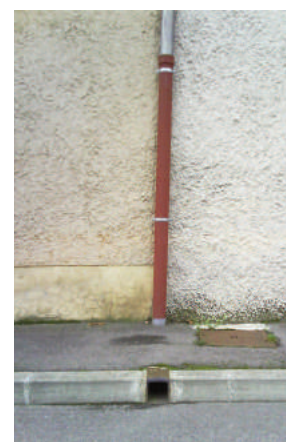
Descente de toiture et gargouille
