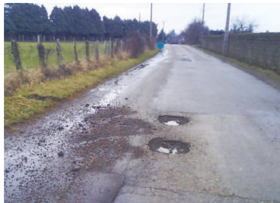
Dégradation de la voie
