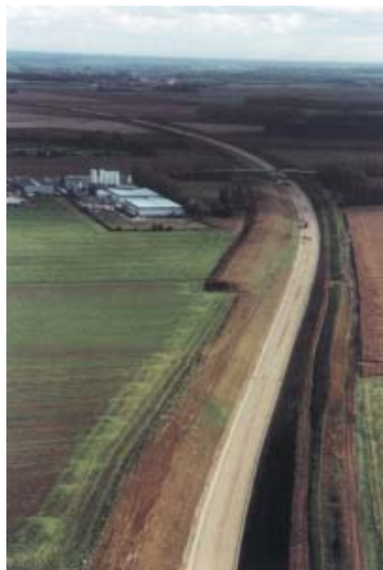
Utilisation pour les travaux TGV
