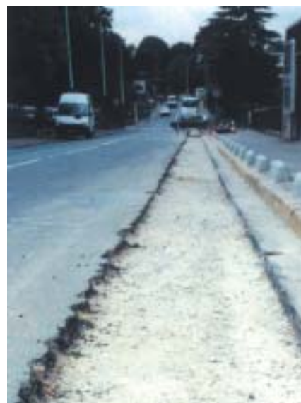
Remblayage de tranchée
