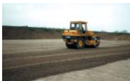
Compactage d'une couche de grave GR2
