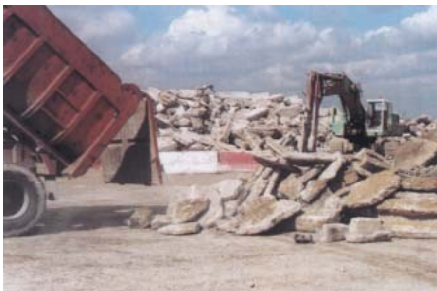
Réception des bétons de démolition
