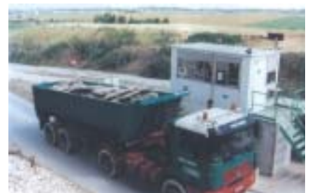
Réception des bétons de démolition
