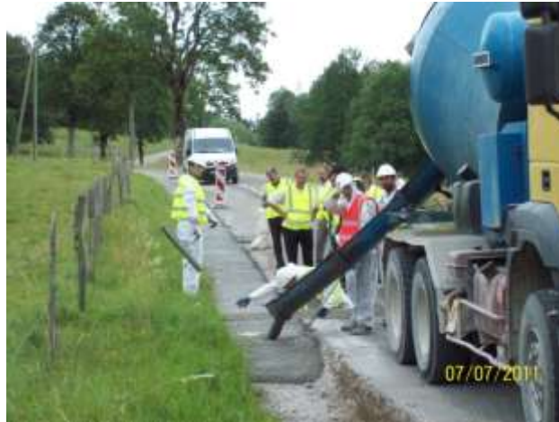
Utilisation des mâchefers en poutre de rive (Bugny-25)
