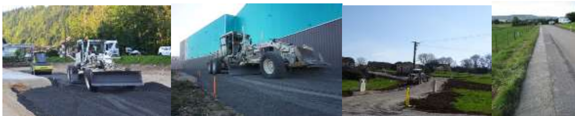
Exemples d'utilisation des mâchefers : voies d'accès zones d'activités, lotissement, RD...
