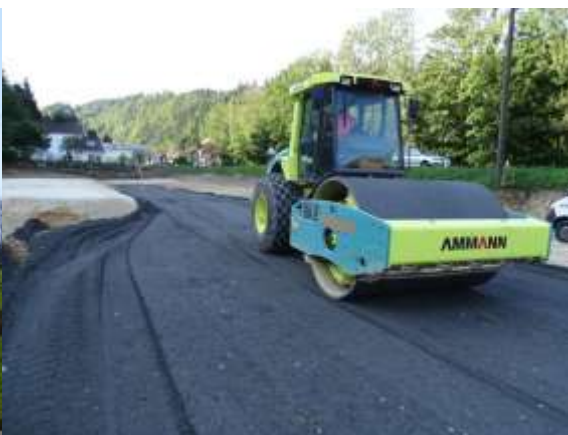
Chantier La Cluse et Mijoux (25)
