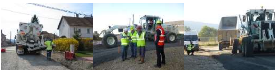
Exemples de chantiers de mise en œuvre
