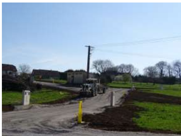
Chantier de Valdahon (25)
