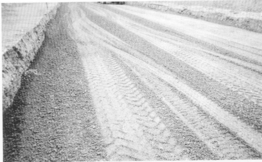
Le mâchefer avant compactage en couche de forme offre une bonne stabilité
