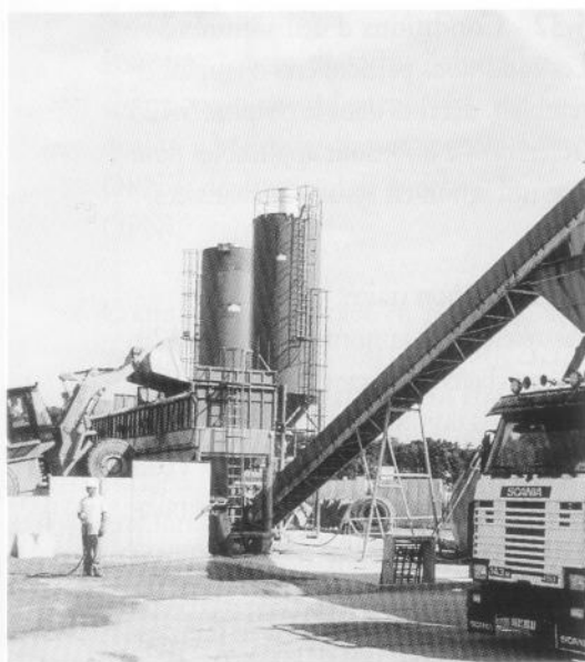
Traitement des MIOM aux liants hydrauliques en centrale de malaxage
