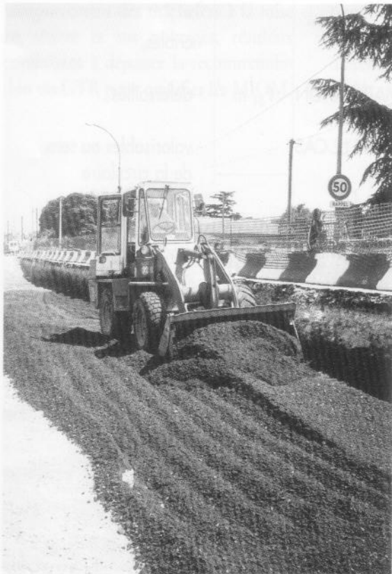
Utilisation de MIOM en assise de chaussée
