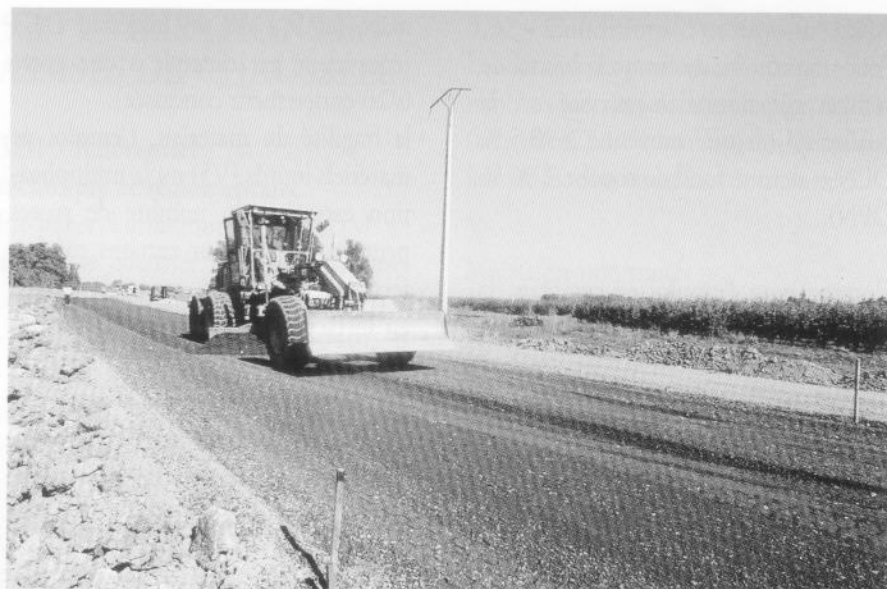
Utilisation de MIOM en couche de forme : RD 471 en Seine-et-Marne
