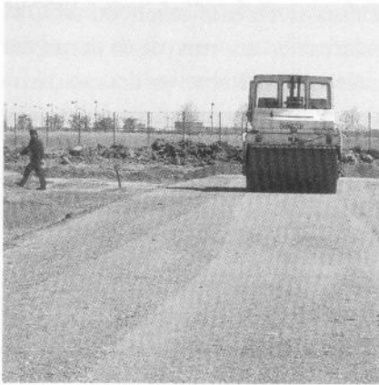
Utilisation de MIOM en couche de forme
