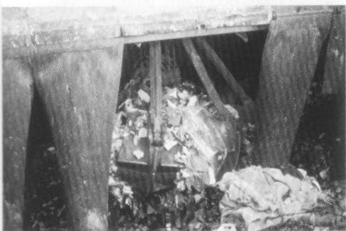
Homogénéisation des déchets avant introduction dans le four
