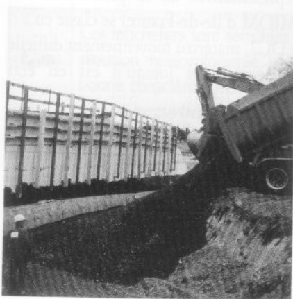
Utilisation de MIOM en remblais : ouvrage d'art sur RN 12
