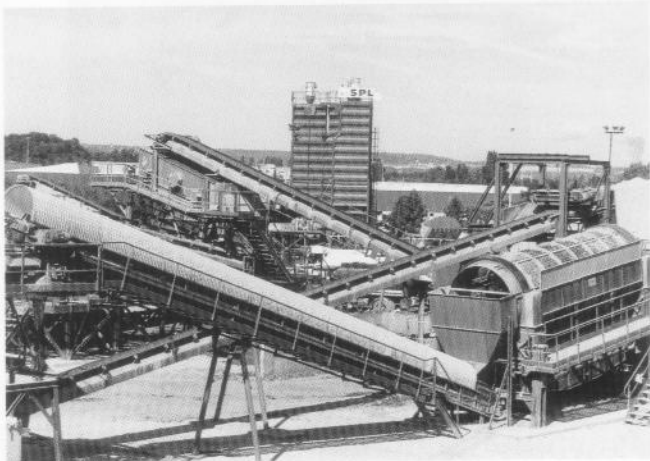
Installation de maturation et d'élaboration des mâchefers
