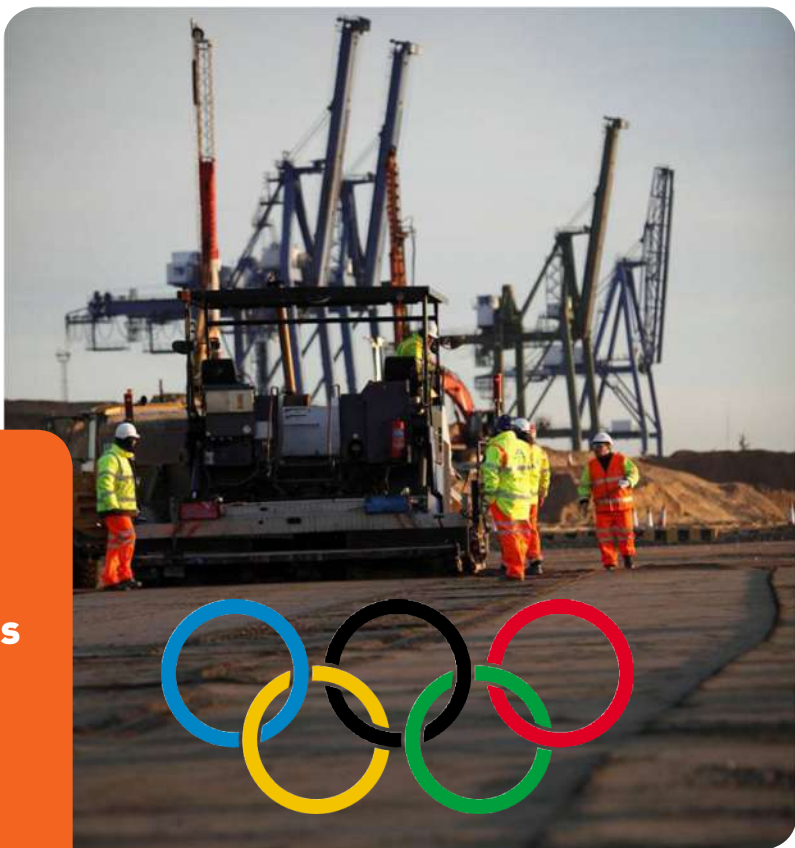
Exemple de chantier à l'international (centre logistique des jeux olympiques de Londres)
