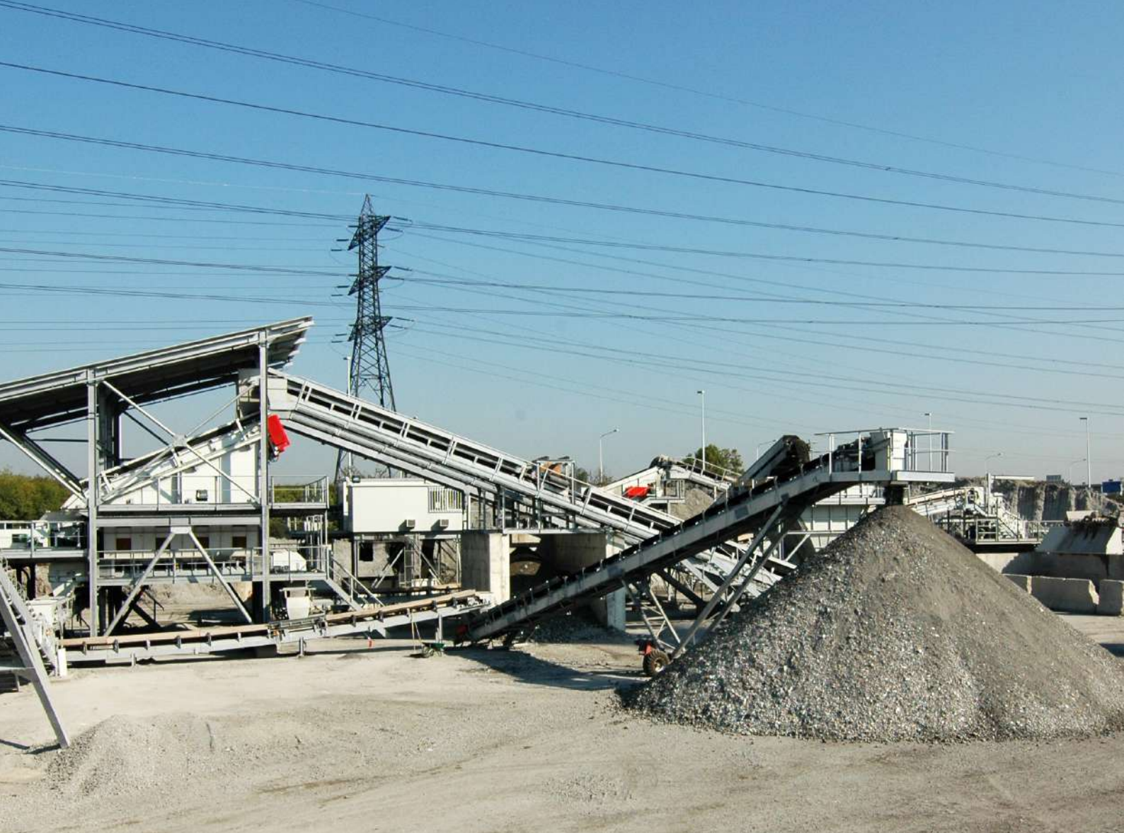
Grave de mâchefer après traitement sur une installation de maturation et d'élaboration (IME)
