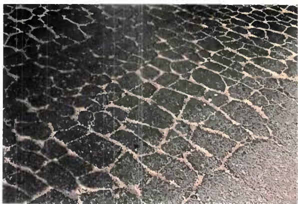
Chaussée avant retraitement.
