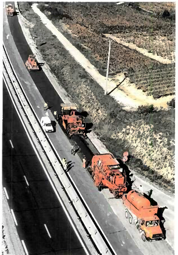
Atelier de retraitement STABICOL (COLAS).
