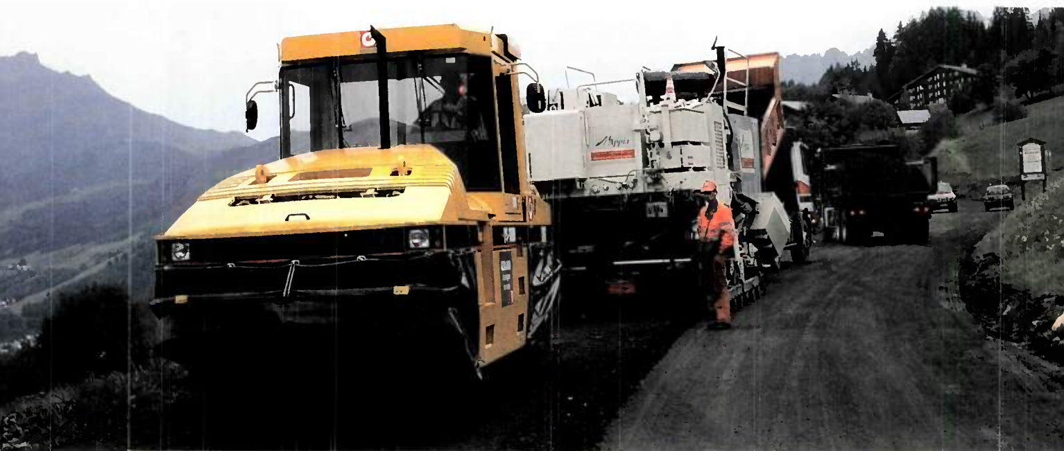
Compactage des matériaux après retraitement - Combelouvière (Savoie).
