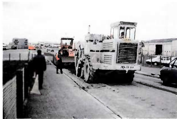
Retraitement en zone industrielle - Pas de réhaussement des abords.
