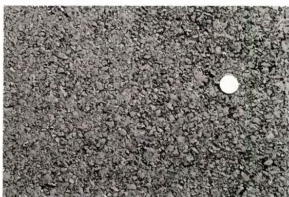
Aspect du matériau retraité à l'émulsion après compactage.
