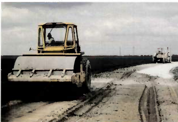
Compactage après retraitement à la RACO.
