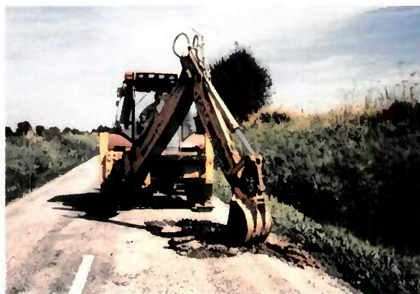
Réalisation de sondages pour prélèvements de matériaux dans la chaussée.
