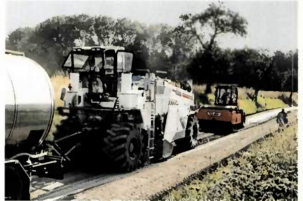
Atelier de retraitement WIRTGEN.
