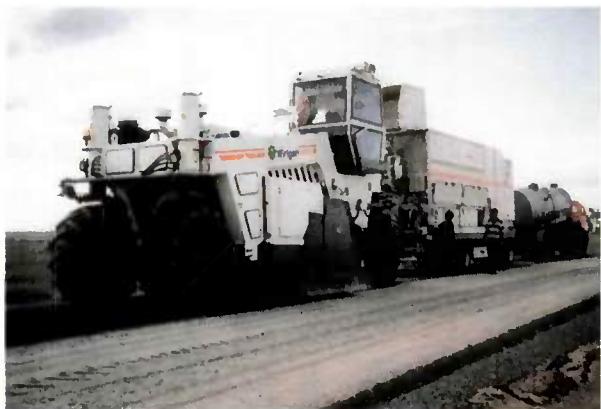
Atelier de retraitement WIRTGEN.
