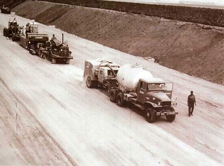
Valorisation de matériaux locaux sur l'autoroute du nord en 1960 "retread process - Vogèle/Beugnetofer".
