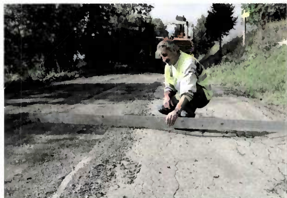
Fraisage préliminaire avant retraitement - Combelouvière (Savoie).
