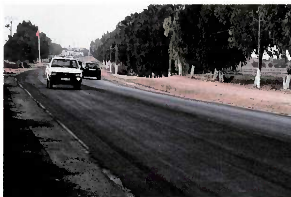
Mise sous circulation immédiate après retraitement à l'émulsion.
