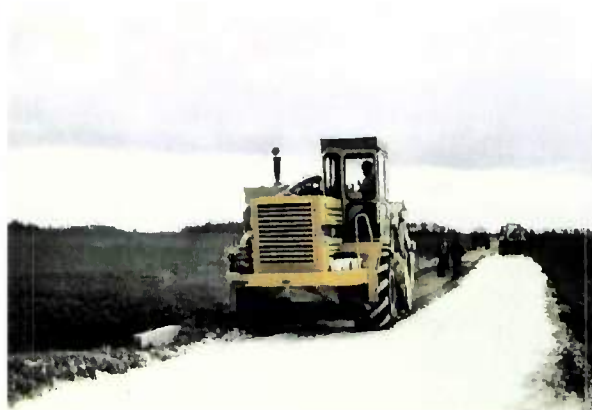
RACO 250 équipée d'une pompe d'injection d'eau sur le côté droit
