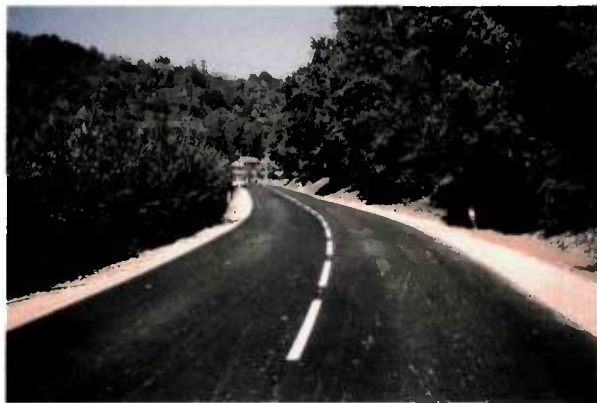
RD 143 Duclair (76) - Aspect de la chaussée après retraitement en place.
