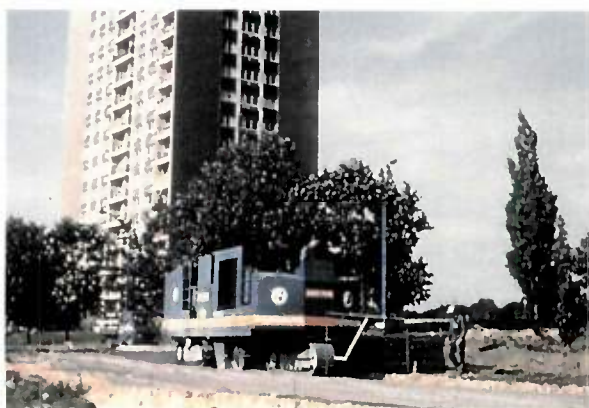
Retraitement au liant hydraulique en agglomération (76).
