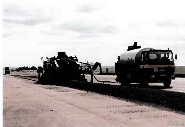
Ajout d'émulsion - Atelier de retraitement RECYCOLD - Aéroport de Limoges Bellegarde.
