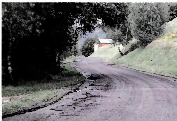
La chaussée avant retraitement - Combelouvière (Savoie).
