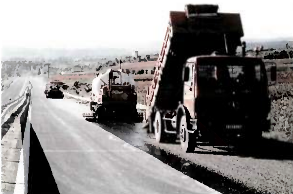
Pose d'un enduit de scellement après retraitement.
