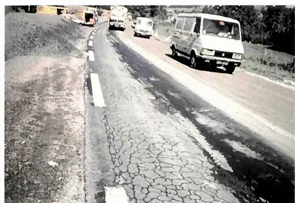
RN 140 Rodez - Avant et après retraitement au liant hydraulique.
