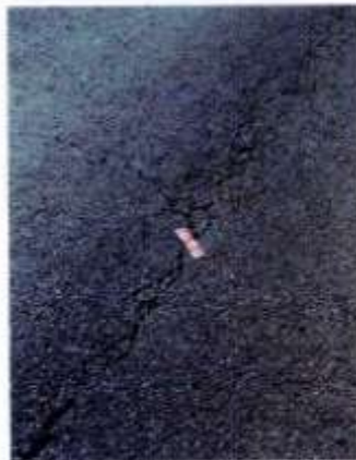
Fissures fines ne nécessitant pas d'entretien avant une intervention généralisée.
