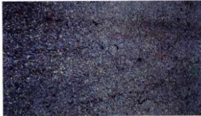
Fissures fines ne nécessitant pas d'entretien avant une intervention généralisée.
