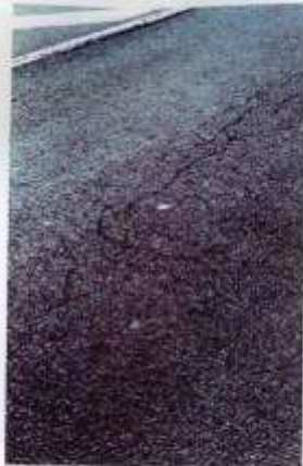
Faïençage fin ne nécessitant pas d'entretien courant
