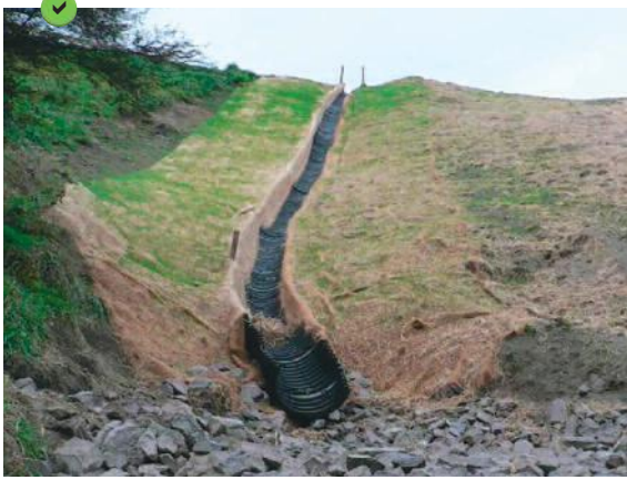
Demi-gaine HDPP sur une surface décapée mais ensemencée et paillée, avec équipement du point de rejet d'un dispositif anti-érosion.
