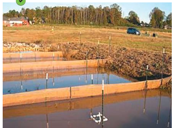
Bassin de décantation dont les talus sont décaissés et végétalisés. Équipement : chicanes en toile de jute fixée à des piquets en acier et vidangeur flottant de type « skimmer ».
