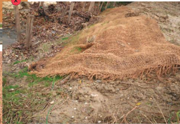
Ancrage insuffisant du filet en amont.
