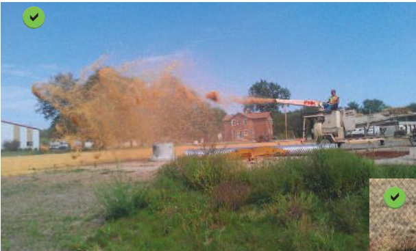
Exemple d'un paillage en cours.
