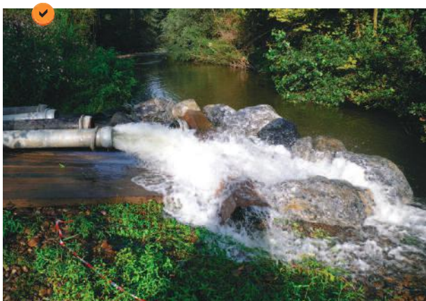
Dispositif temporaire de protection de points de rejet à l'aide d'une plateforme en plats-bords complétée d'un demi-cercle de blocs rocheux de 100 kg à 200 kg. Le choix des dispositifs anti-érosion dépend du débit du point de rejet et des enjeux associés au cours d'eau.
