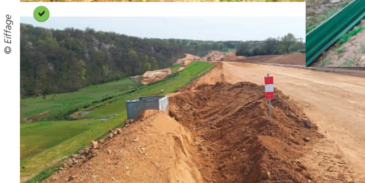
Fossé de collecte des écoulements superficiels.
