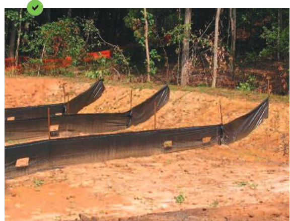
Fixation correcte des barrières géotextile.
