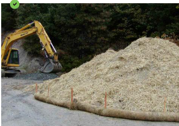
Couverture du dépôt provisoire à l'aide d'un paillage par mulch et contrôle du périmètre à l'aide d'un boudin de rétention.
