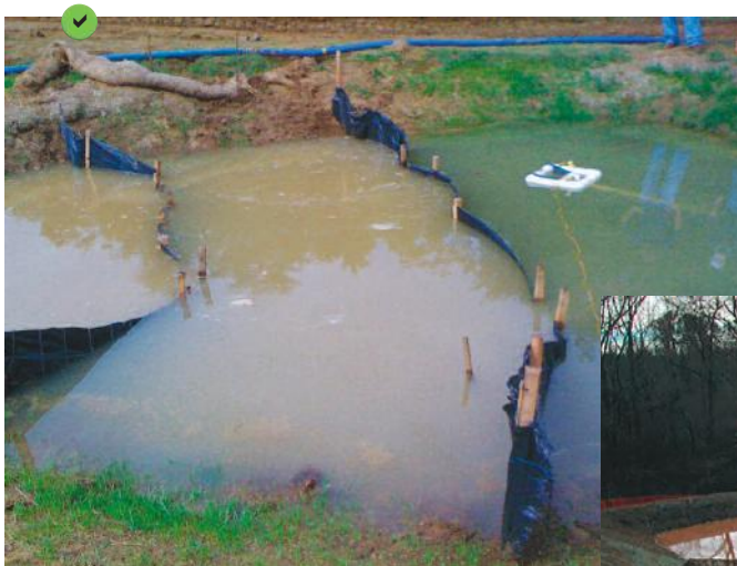
Bassin de décantation équipé de barrières perméables. L'abattement de la turbidité est visible. Attention néanmoins à ce que le niveau d'eau ne dépasse pas celui des barrières perméables.
