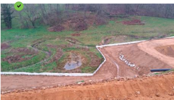
Barrière de rétention longeant un cours d'eau.
