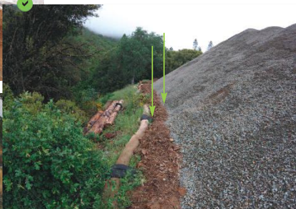
Contrôle du périmètre coté bas d'un dépôt provisoire à l'aide d'un merlon de copeaux de bois et d'un boudin de rétention.
