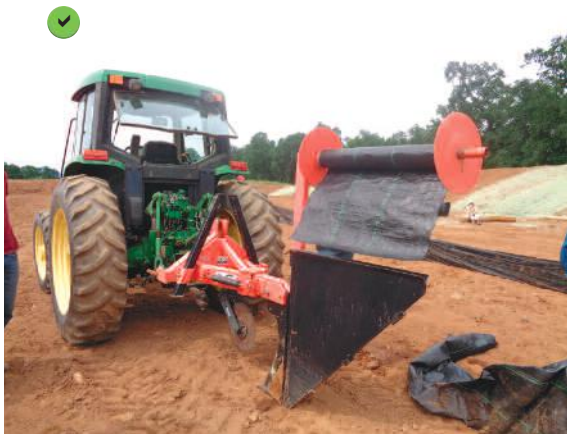
Dispositif d'installation automatique des barrières de rétention.
