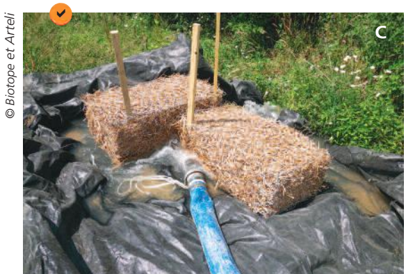
C, D - Exemples de deux dispositifs temporaires de protection des exutoires (utilisés pour quelques jours uniquement). L'option « botte de paille » n'est pas la plus économique ni la plus efficace.
