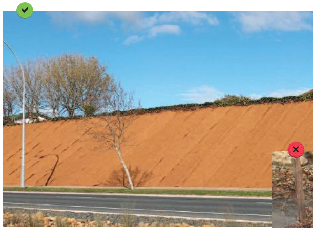
Reprise de talus routier à l'aide d'un géotextile coco.
