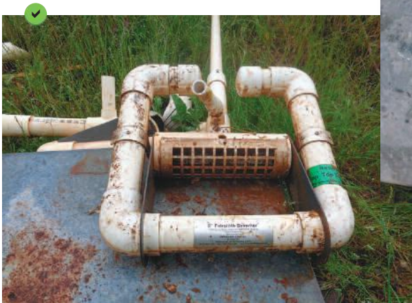
Installation d'un skimmer au sein d'un bassin de décantation provisoire.
