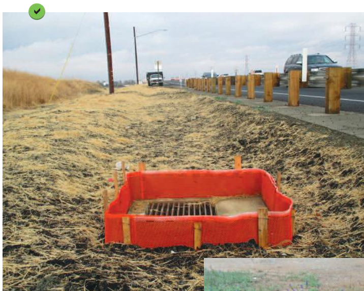
Type 1 : barrière périphérique en toile de géotextile tendue et associée à un paillage du fossé collecteur.
