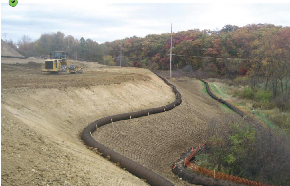
Approche multi-barrières appliquée à un talus découpé : lutte contre l'érosion par chenillage des sols, infiltration des écoulements superficiels à l'aide de boudins de rétention en série, maintien d'une zone tampon entre le chantier et le cours d'eau par mise en défens de la ripisylve
