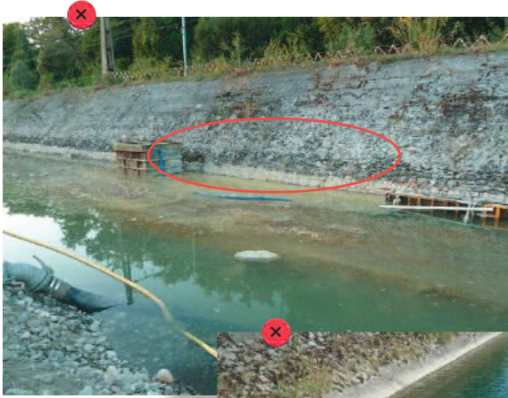
Lessivage de la laitance d'un coffrage suite à un arrêt trop précoce des pompes et pompage incomplet de la laitance dans le bac de traitement.
