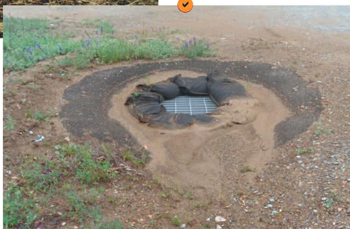
Type 1 : barrière périphérique en sac de graviers. Fonctionnelle mais à désen-graver.
