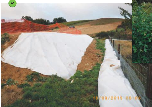
Couverture du dépôt provisoire à l'aide d'un géotextile non tissé.
