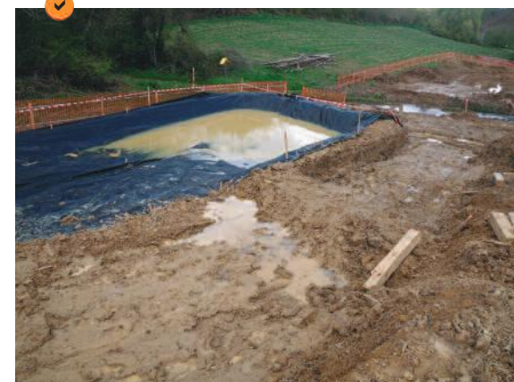
Piège à sédiments hors-sol : rapport longueur/largeur adapté, mais absence d'un dispositif de surverse.
