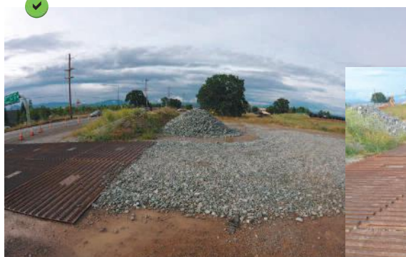
Fosse drainante et grille métallique ondulée.
