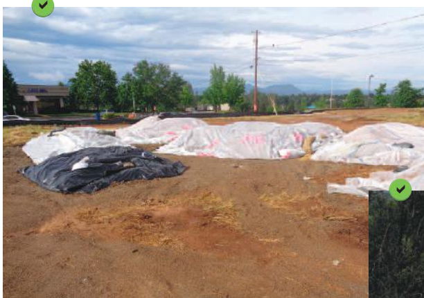
Protection de dépôts provisoires à l'aide de géomembranes.
