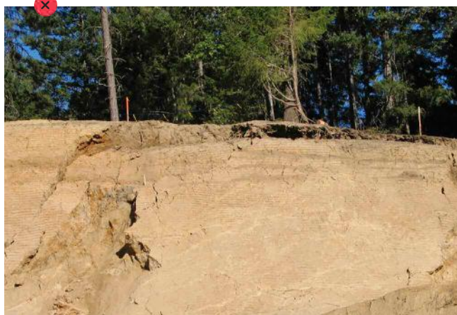
Glissement de terrain en cours.
