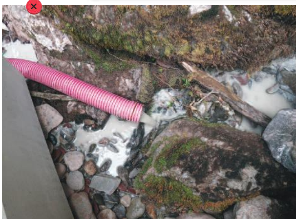
Rejet de laitance béton en milieu naturel.
