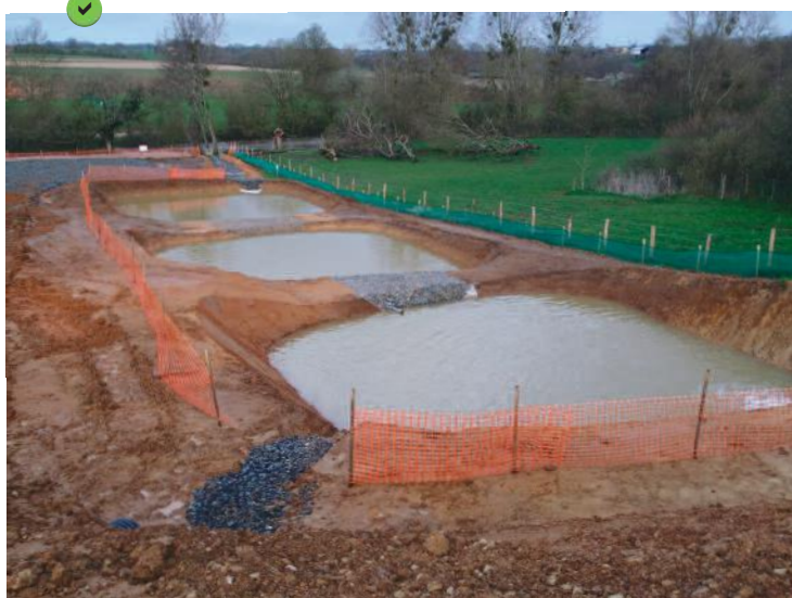
Bassin de décantation constitué de trois sous bassins successifs.
