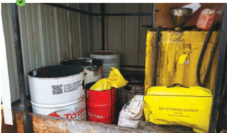
Exemple d'une aire de stockage des matériaux polluants, constituée d'un conteneur/bungalow étanche associé à un kit anti-pollution. Certains produits sont isolés du sol et disposés sur des bacs de rétention.
