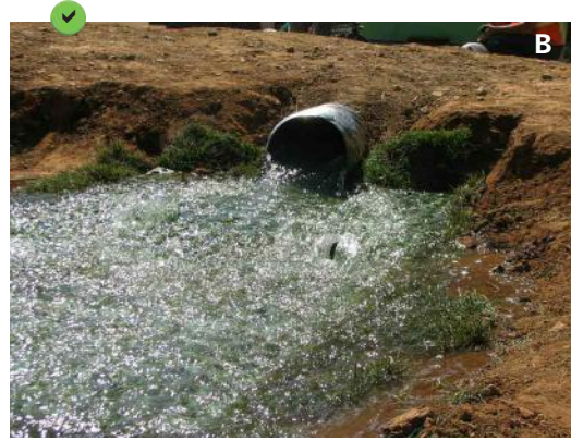
A, B - Protection d'un point de rejet à l'aide d'un tapis laminaire PEHD. Le tapis favorise l'étalement de la lame d'eau et dissipe l'énergie hydraulique. Les faibles turbulences à la surface de l'eau permettent la reprise végétale, protégeant d'autant plus efficacement les sols contre l'érosion.
