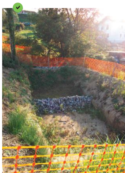
Barrière perméable réalisée à l'aide d'un tas de granulats grossiers.
