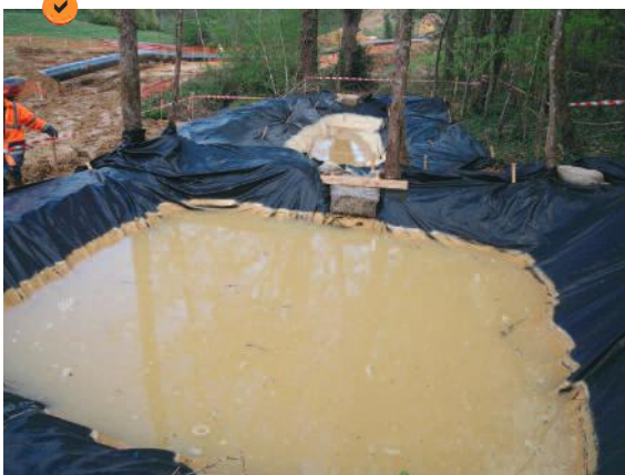
Dispositif de surverse à gabion de paille.
