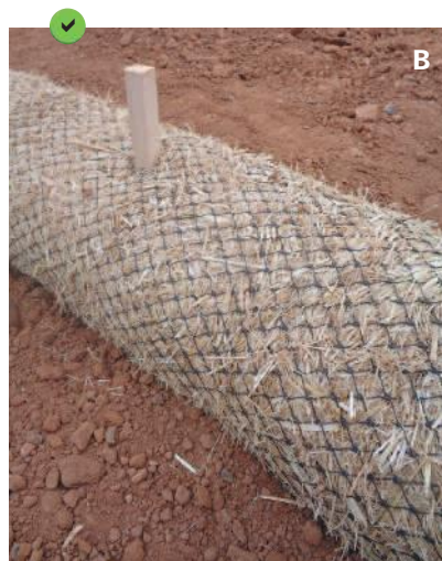
Boudins avec maillage plastique et rembourrage en fibre de paille, ancrés par pieux alternés (A) ou selon la technique "vampire" (B).
