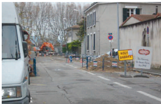
Rue en chantier
