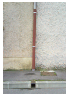
Descente de toiture et extrémité de gargouille
