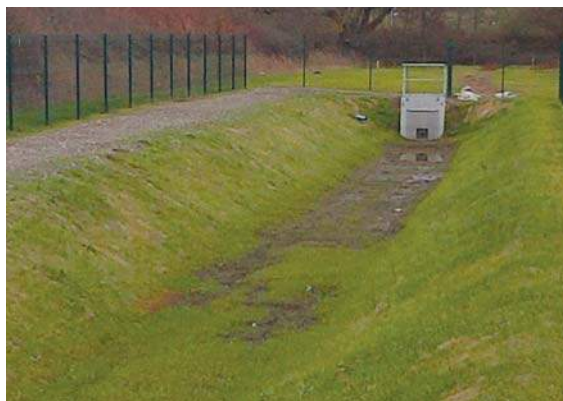
Bassin de rétention
