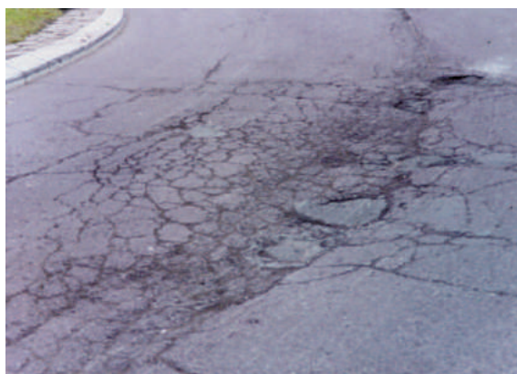
Défaut d'entretien du revêtement de la chaussée
