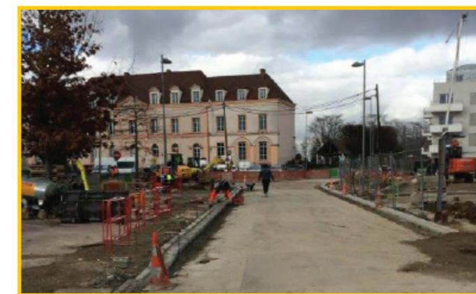
photo du chantier
