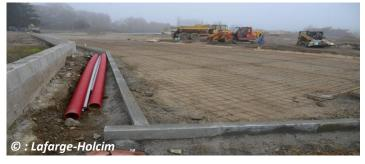
Le parking de Chaponost (Rhône) a été le premier chantier expérimental du Projet National Recybéton, visant à démontrer la faisabilité opérationnelle du recyclage du béton. Ce chantier, mené en décembre 2013, a porté sur la réalisation d'un dallage d'une épaisseur de 18 cm sur 2 100 m2, destiné au parking d'une entreprise de travaux publics. Afin de tester au mieux le comportement et l'évolution des bétons recyclés, la dalle a été divisée en 6 zones incorporant de 0 à 100% de granulats recyclés.
