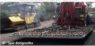
En avril 2018, l'entreprise Malet, filiale du groupe Spie Batignolles, a mis en œuvre la seconde phase de son expérimentation concernant la réfection d'une chaussée de 1 000 m<sup>2</sup>, menée dans le cadre du projet national Mure. Ce chantier réalisé à Portet-sur-Garonne, près de Toulouse, doit valider in situ, grâce au vieillissement accéléré, les expérimentations menées en laboratoire pour la réutilisation des agrégats d'enrobés.
