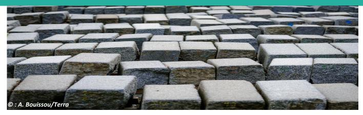
Dans le cadre du chantier de prolongement du T3 parisien en 2012, les bordures de trottoirs et les pavés retirés de la chaussées ont été récupérées et , après redécoupe et sciage sur plateforme de recyclage, réemployées sur le chantier du tramway pour la délimitation des pistes cyclables et l'élargissement des trottoirs existants.
