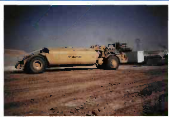
Arroseuse de grande capacité (supérieure à 80 m 3 ) adaptée à la nécessité d'élever de plusieurs points la teneur en eau d'un limon de classe A 2 5 destiné à la réalisation d'une couche de forme traitée avec un liant hydraulique.
