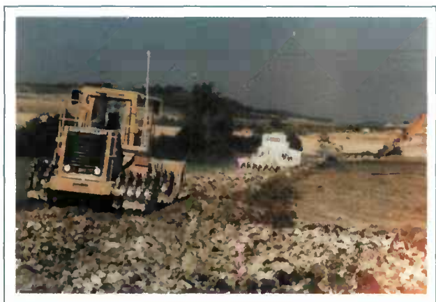
Dans le cas de traitement « au remblai », le compactage à l'aide de compacteurs à « pieds dameurs » participe avantageusement à l'aération et au malaxage des sols argileux humides.
