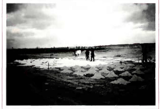
L'épandage au sac est techniquement acceptable, mais économiquement ne peut se justifier que sur des surfaces exigües et de géométrie complexe.
