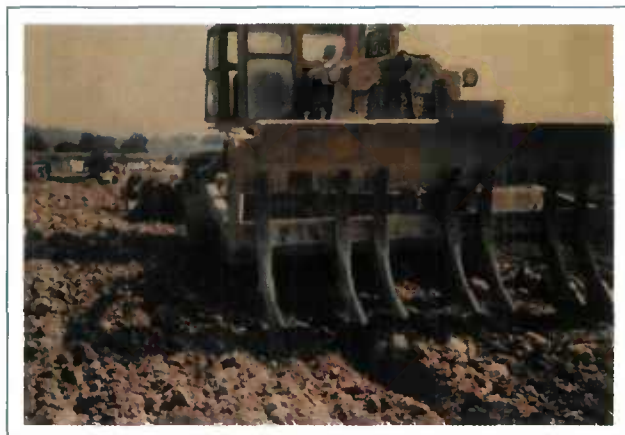
L'association sur le même tracteur d'une charrue (à disques dans ce cas) et d'une lame spéciale équipée de socs, dont l'écartement a été fixé d'après le D_{max} du matériau, s'est avérée une bonne solution technique et économique pour mélanger des moraines glacières (classes C_1B_4h ) avec de la chaux vive.
