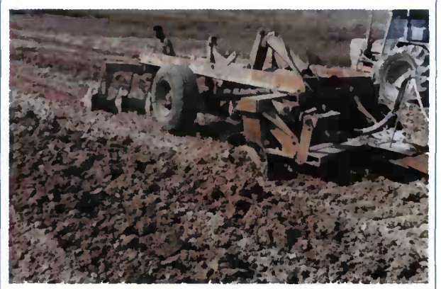
Malgré son poids et le diamètre de ses disques, la profondeur de malaxage ne dépasse pas 0,20 m. Toutefois, une mouture satisfaisante est rapidement obtenue (au premier plan, mouture obtenue après une passe, et au second plan celle obtenue à la seconde passe).
