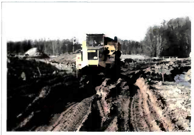
Conditions limites de circulation sur des graves limoneuses B 3 h (profondeur d'ornière de plus de 0,2 mètre).
