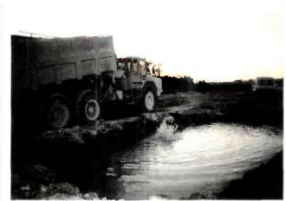
Filtre humide constitué d'une fosse remplie d'eau périodiquement renouvelée.
