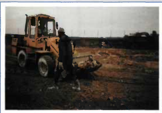
Le ramassage manuel des blocs une fois remontés en surface par scarification peut être une solution acceptable sur de petits chantiers (plate-forme industrielle, par exemple).
