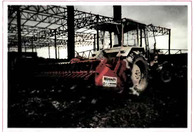
Rotobêche. Largeur 3 m, épaisseur maximale de la couche malaxée 0,30 m (après compactage). Tracteur de 150 CV.
