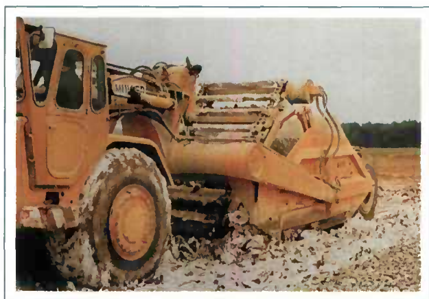
La qualité du malaxage obtenue avec des charrues peut être très sensiblement améliorée si la reprise du mélange est réalisée avec des décapeuses auto-chargeuses.
