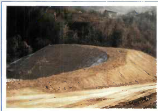
Exemple de dépôt provisoire de moraine glaciaire (classe C_1B_5m ) aménagé en divers points du tracé pré-criblée en vue de sa reprise pour traitement en place avec un liant hydraulique.
