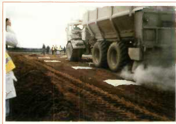
Épandage du produit de traitement sur la section d'essai.
