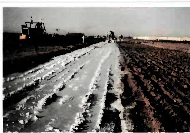
Épandage de lait de chaux pour traitement en couche de forme d'un sol argileux.
