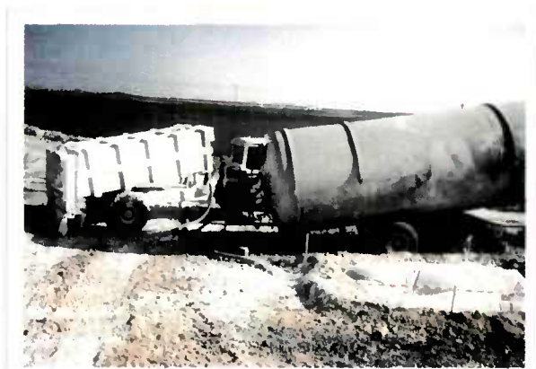
Filtre sec constitué d'une fosse recouverte d'un géotextile non tissé.
