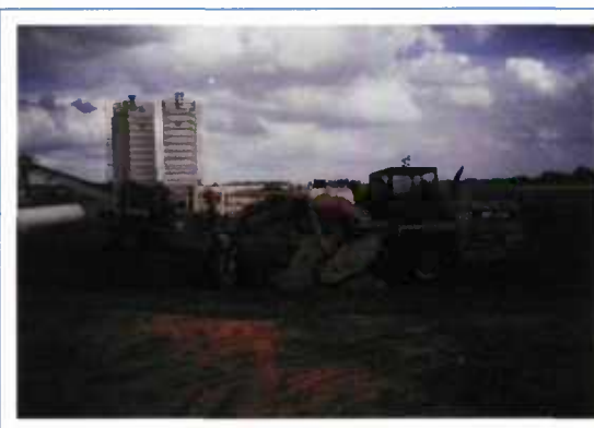
La fabrication en centrale nécessite d'aménager des stocks à proximité des trémies d'alimentation des doseurs. Sur la photo, le matériau stocké étant constitué par un limon prétraité à 1,5 % de chaux vive, il est nécessaire au moment de la reprise de le refoisonner à l'aide d'un gros pulvérisateur, pour permettre son écoulement correct dans les organes de la centrale.
