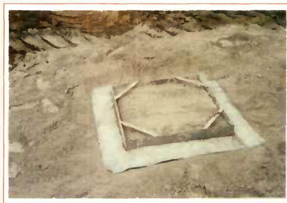
Élimination du produit de traitement situé sur la bâche à l'extérieur du cadre.
