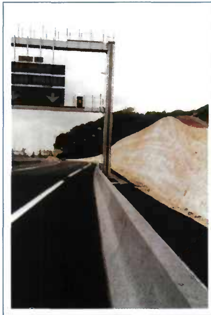
Soutènement d'un talus de déblai dans un limon réalisé avec de la craie traitée avec un liant hydraulique (hauteur maximale : 6 m, pente : trois vertical pour un horizontal).
