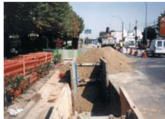
Exemple de réalisation de chantier en Ile-de-France
