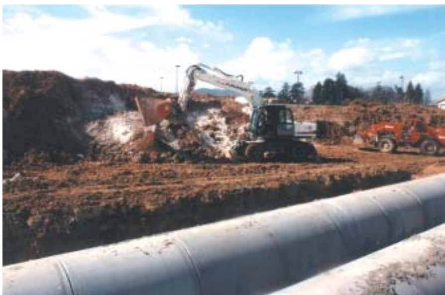
Chantier mobile en région lyonnaise utilisant un godet cribleur et un silo à vis de dosage télécommandée
