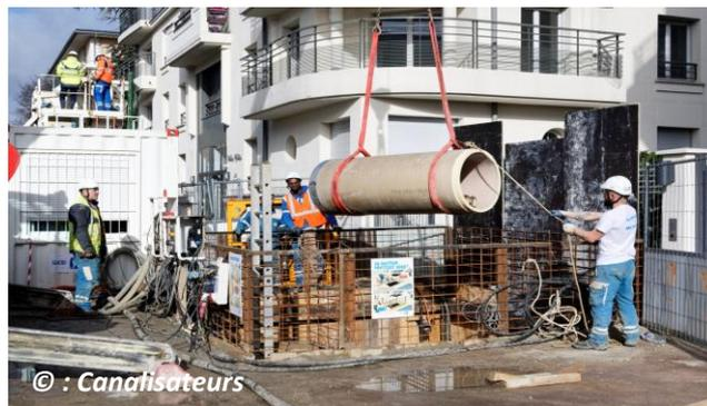
Dans le cadre de la mise en œuvre du Tramway T10 entre Antony et Clamart, le Conseil Départemental des Hauts de Seine, doit dévier l'ensemble de ses réseaux impactés par la plateforme du futur tramway. Afin de limiter les nuisances et les volumes de terrassement dans une zone fortement urbanisée, plus de 2km de réseaux en PRV DN600 sont mis en œuvre par microtunnelage. Le déplacement de plus de 25 000 m3 de matériau seront épargnés par l'emploi de cette technique.
