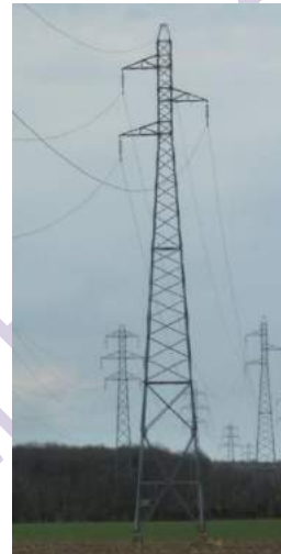
Réseau aérien HTB de 90 kV
