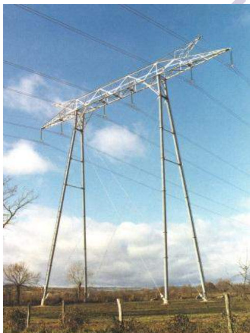
Réseau aérien HTB de 225 kV
