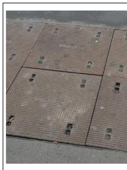
Installation électrique de gare
