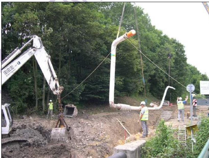
Illustration d'une baïonnette en cours de pose
