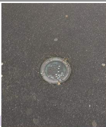
Eclairage par le sol
