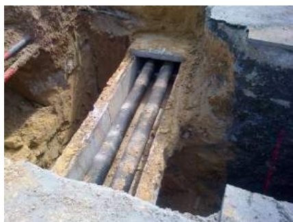
Réseau en caniveau
