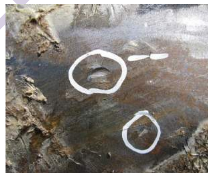
pioche / canalisation acier gaz HP
