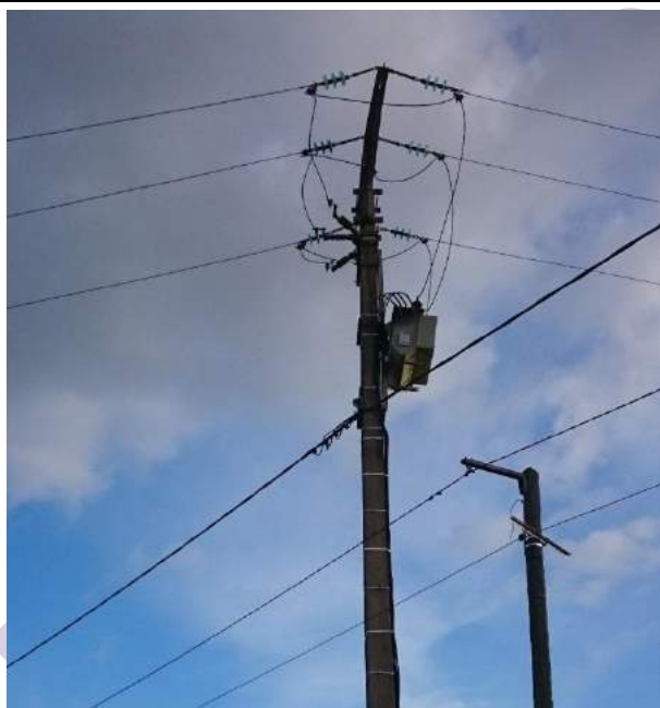
Réseau aérien BT torsadé sur support HTA
