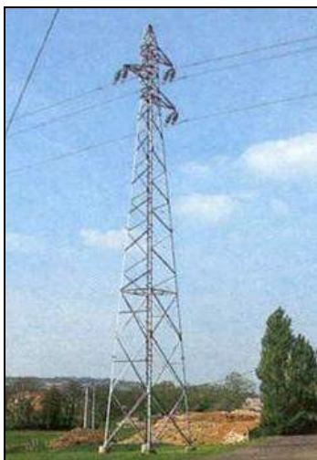
Réseau aérien HTB de 63 kV sur pylône
