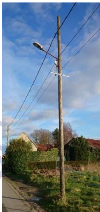
Eclairage public sur support bois commun
