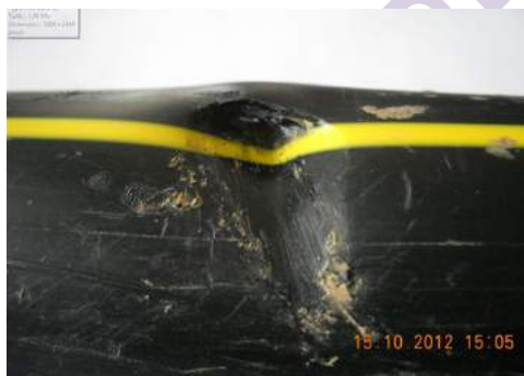
barre à mine / canalisation PEHD gaz MPB
