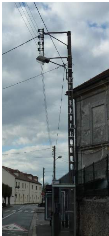
Eclairage public BT sur support béton commun
