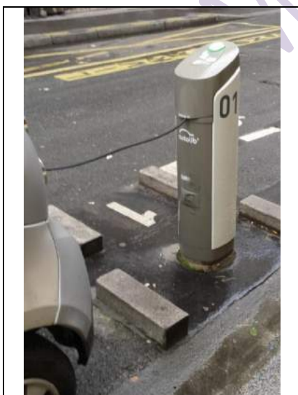
Borne de recharge électrique
