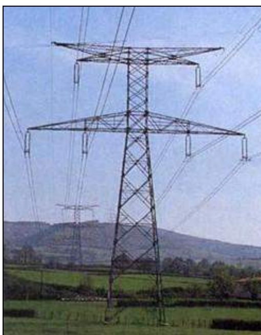
Réseau aérien HTB de 400 kV
