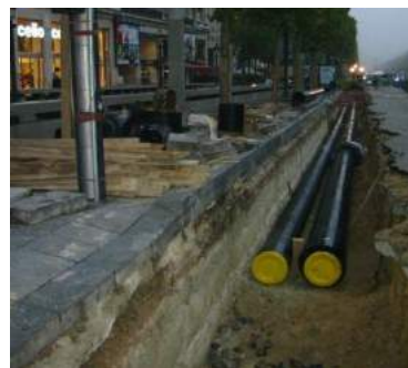
Réseau en pleine terre
