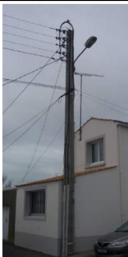
Réseau aérien BT sur support commun
