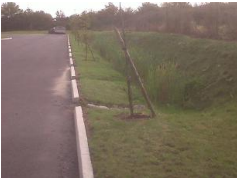
Exemple de noue – au premier plan, dispositif d'admission dans la noue (crédit image FP)
