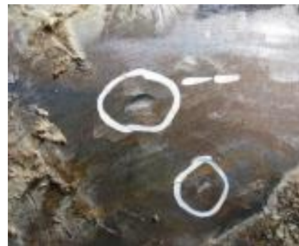
pioche / canalisation acier gaz HP
