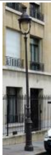
Éclairage public - Luminaire
