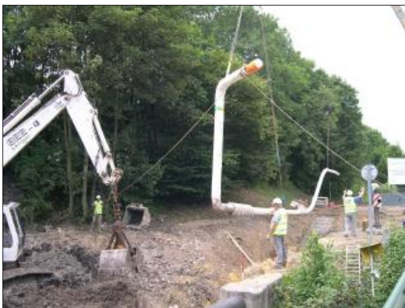
Illustration d'une baïonnette en cours de pose
