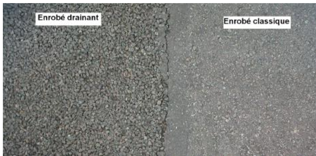
Enrobés drainant et classique (crédit FP)
