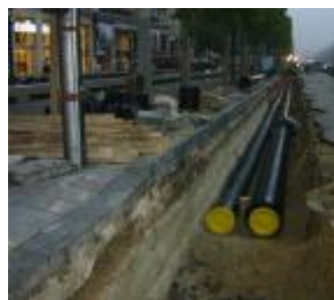
Réseau en pleine terre
