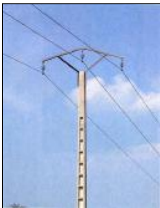
Réseau aérien HTA à conducteurs nus sur poteau béton
