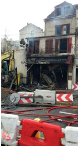
En tirant sur le branchement avec le godet de la pelle mécanique, le détendeur a semble-t-il été arraché dans le sous-carter visible sous le trottoir. Une accumulation de gaz s'est alors produite dans la cave d'un café.
