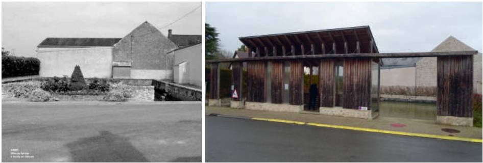
Figures 7.1 et 7.2. Avant et après l'aménagement de la mare de Verrine, Bouilly-en-Gâtinais : rénovation du bassin, construction d'un abribus en bois, création d'un trottoir
