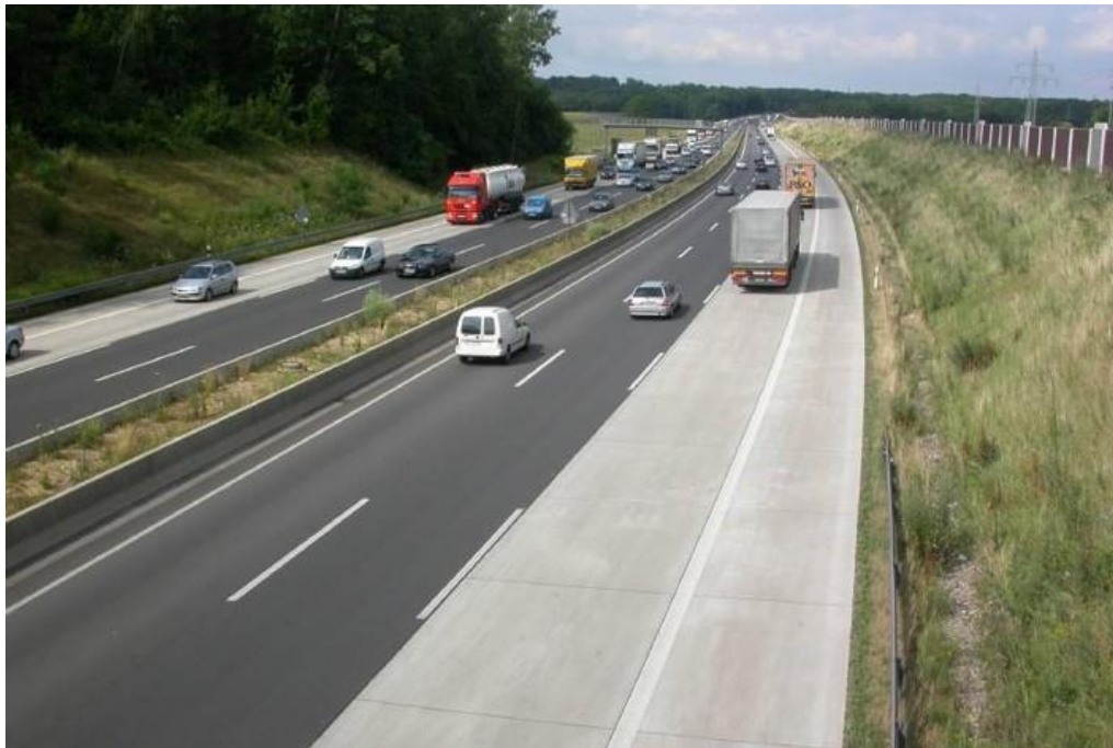
Figure 7.2.3-1 : site d'essai sur l'autoroute A61 en Allemagne
