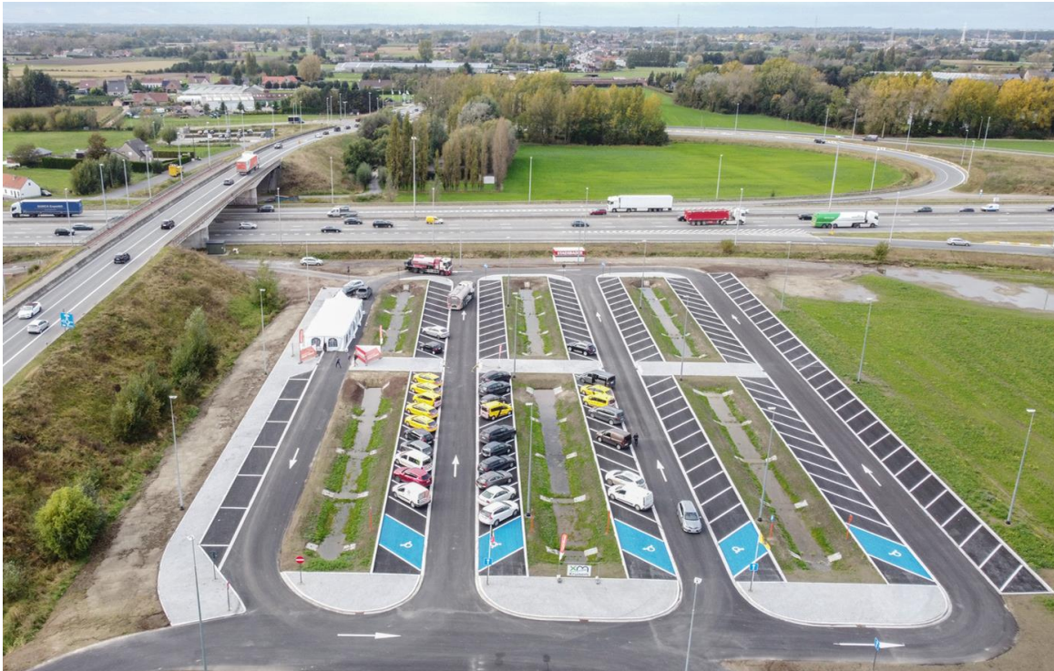
Figure 7.3.3-1 : Parking de covoiturage à Kruisem avec prairies d'infiltration, fossés d'infiltration et revêtements bitumineux perméables (photo : Agence des routes et de la circulation, Belgique)
