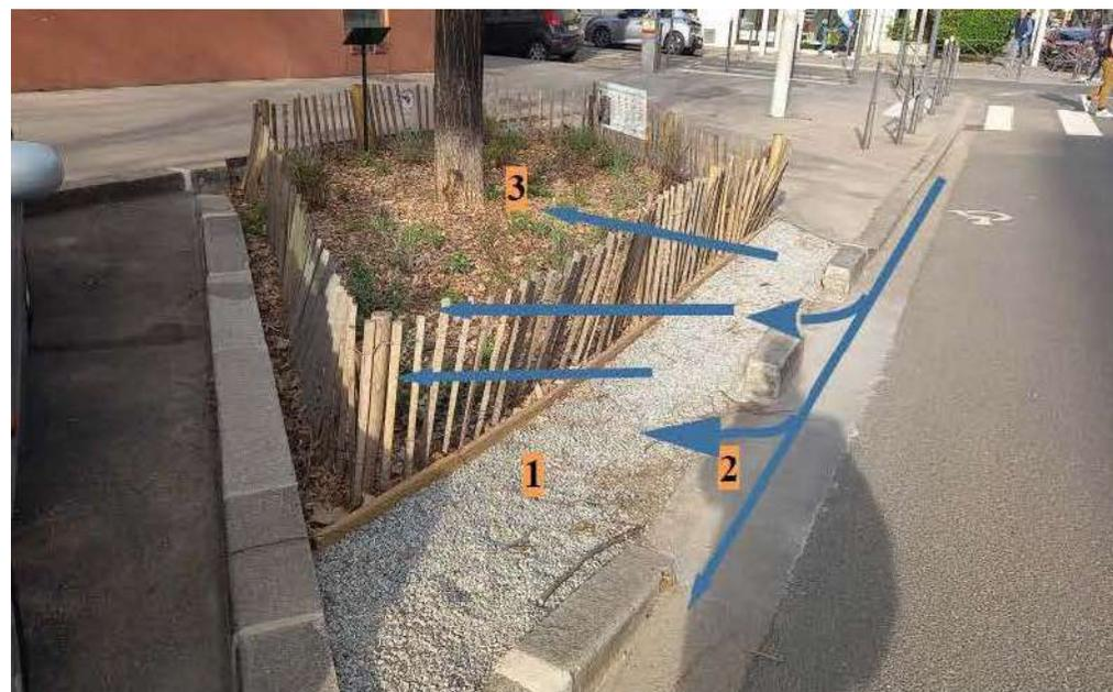
Illustration 43 : Dispositifs de gestion des eaux pluviales favorisant l'infiltration des pieds d'arbres. Les flèches bleues indiquent le sens d'écoulement des eaux de ruissellement.
