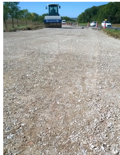
©Eurovia SMC : Grave recyclée SMC CD14 Bretelle d'accès RD8 chantier EUROVIA
