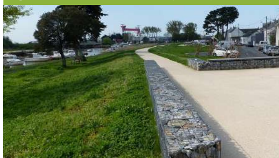
Digue de Méan à Saint Nazaire (Cerema)
