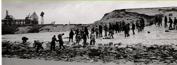
Réfection de la digue des alliés à Dunkerque après la tempête de 1953 (source : CUD)
