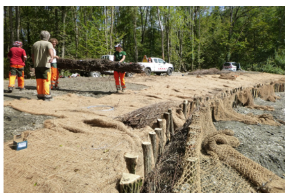
Reconstitution d'une berge érodée du gave d'Azun avec des fascines de saules (source : PLVG)
