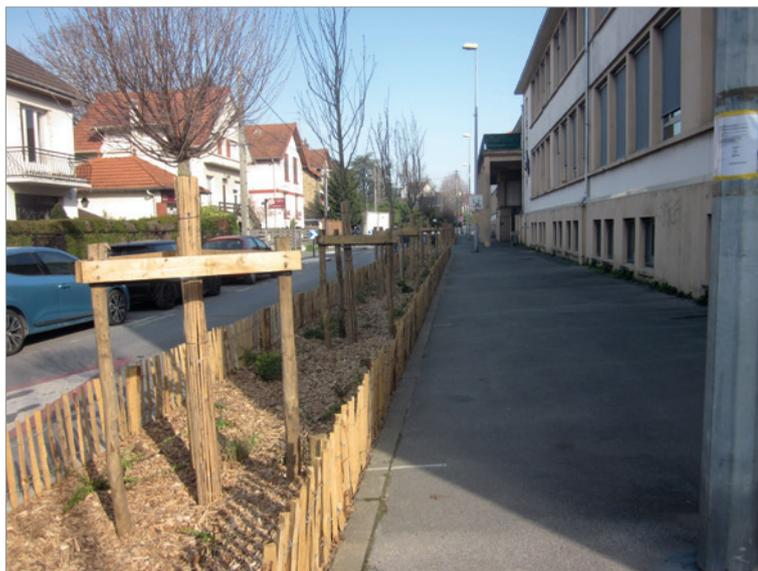
*Aménagement sur un trottoir pour faciliter l'infiltration des eaux pluviales à Chelles.*
