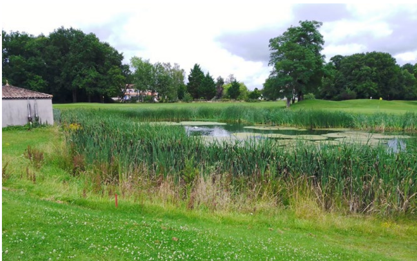
Illustration 15 - Lagune aérée et paysagée du golf de Saintes (100 m 3 ). L'eau issue de la STEU de Lormont (Boue activée, 40 000 EH) est filtrée avant son lagunage, puis désinfectée avant son utilisation pour l'arrosage du golf.
