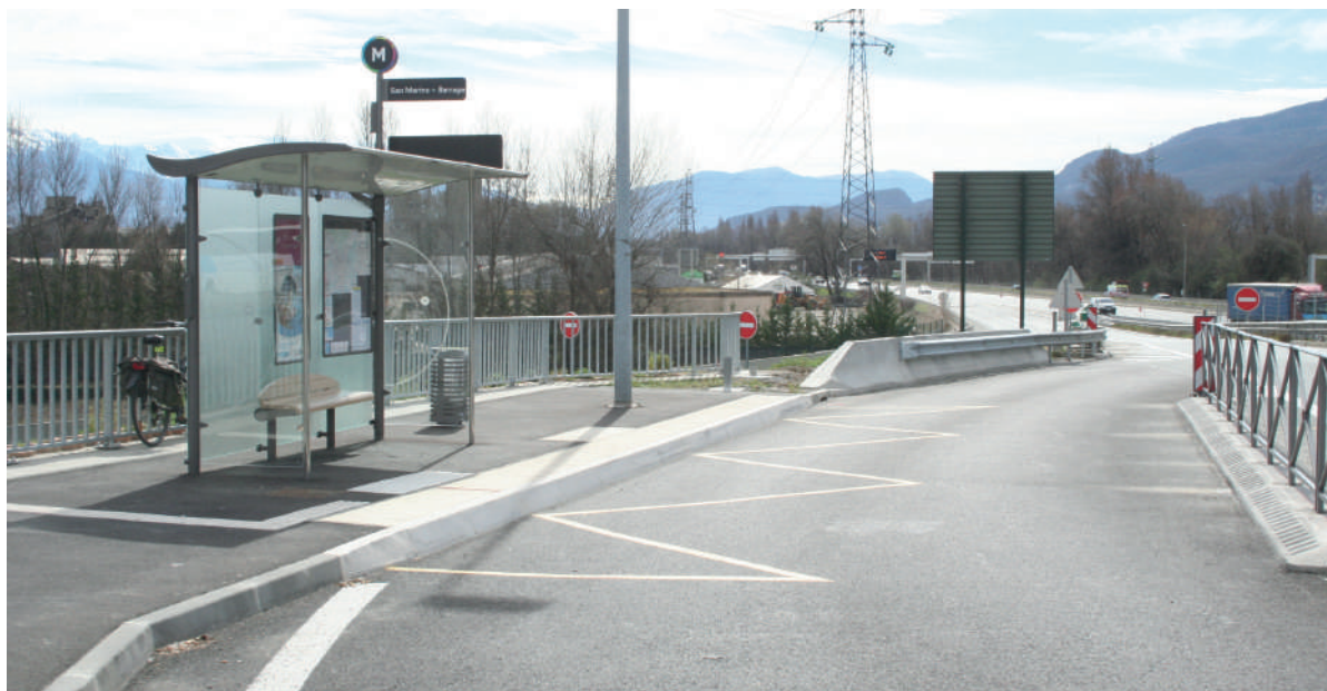
Aménagement d'un arrêt TC séparé sur une bretelle de sortie – A48 Saint-Égrève
