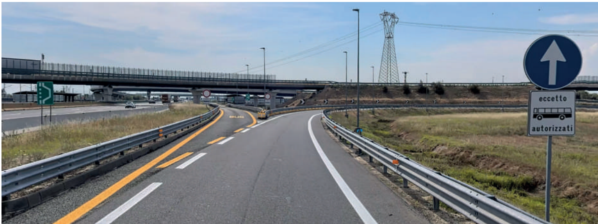
Cas d'une sortie par la gauche sur bretelle sur Autoroute A4 – Italie
