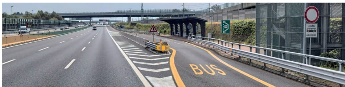
Arrêt de bus sur l'A4 à Galliate
