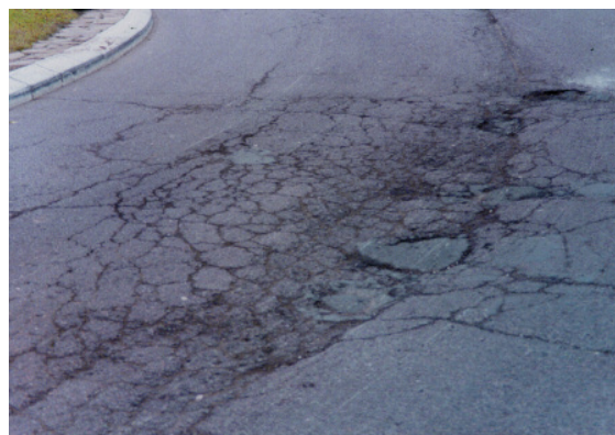
Défaut d'entretien du revêtement de la chaussée
