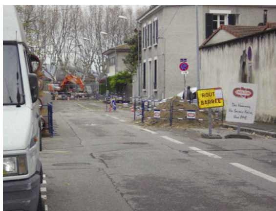
Rue en chantier
