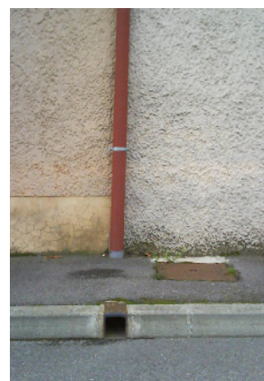
Descente de toiture et extrémité de gargouille
