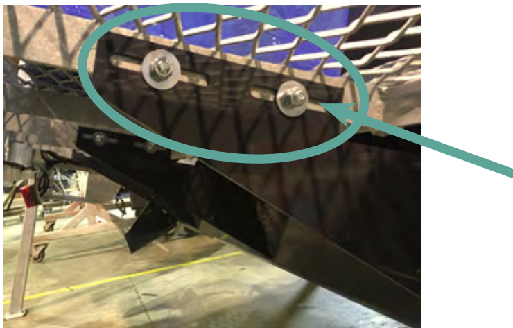
Figure 22 : Vue des trous houlbons du contre-diffuseur (source : Secmair)
