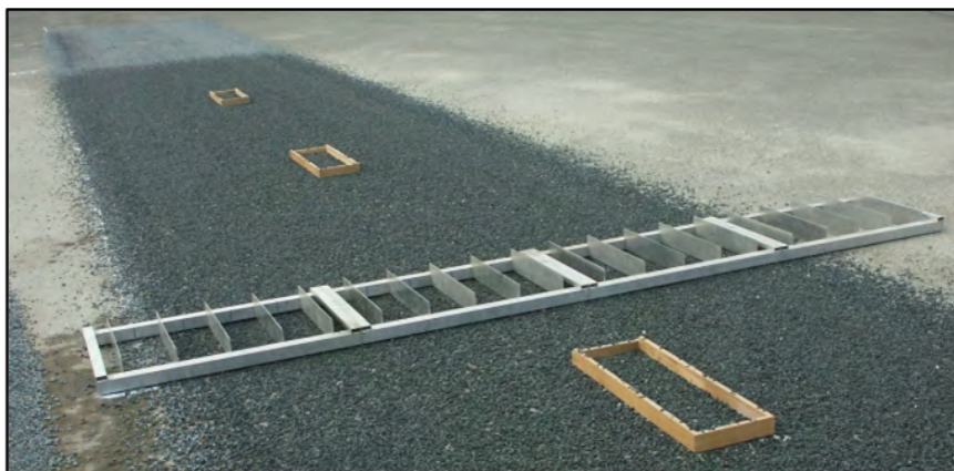
Figure 30 : Vérification du dosage et de la répartition sur chantier
