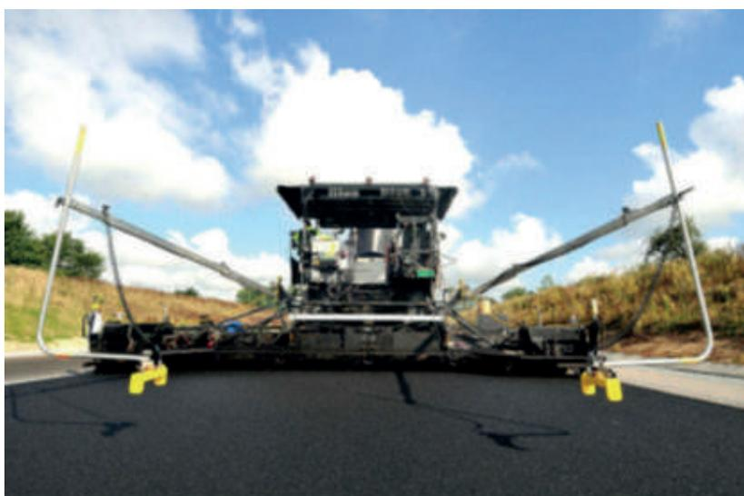
Photo 13 : Dispositif de poutre virtuelle
