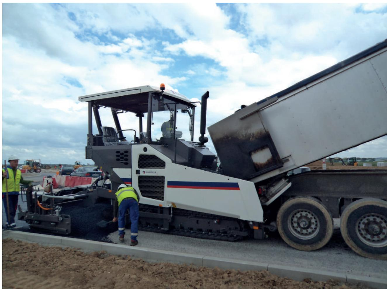
Photo 15 : Finisseur équipés de dispositif d'aspiration
