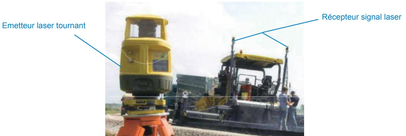
Photo 14 : Dispositif de laser tournant
