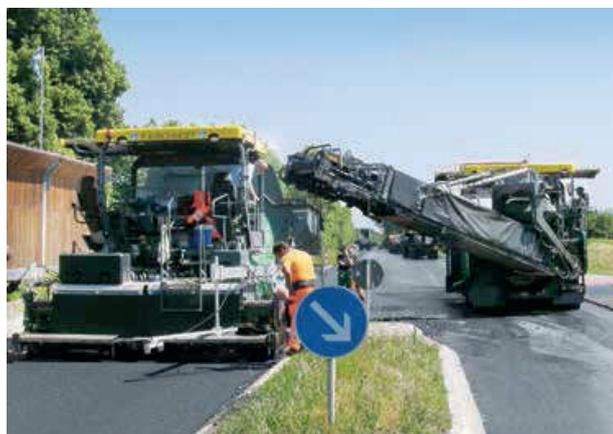
**Photo 4** : Exemple d'alimentation d'un finisseur en déporté
