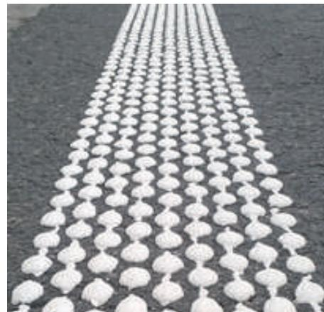
Figure 25 : Exemple de marquage VNTP en enduit à chaud
