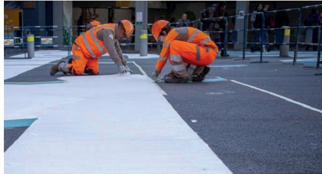
Figure 14 : Application d'enduits à froid
