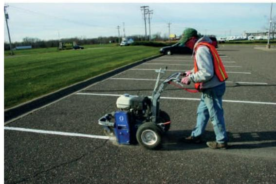
Figure 55 : Ponçage d'un marquage
