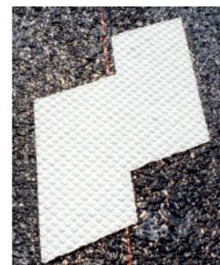
Figure 16 : Illustration d'une bande collée à froid
