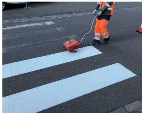
Figure 50 : Application de bandes préfabriquées collées à froid
