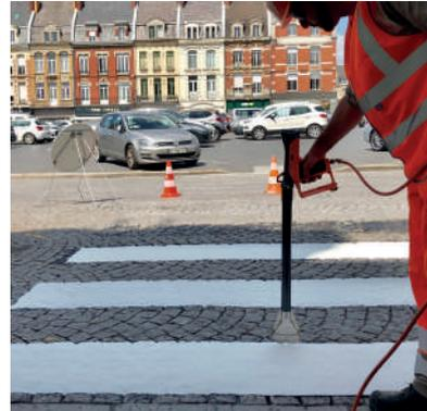
Figure 49 : Application de bandes préfabriquées thermocollées
