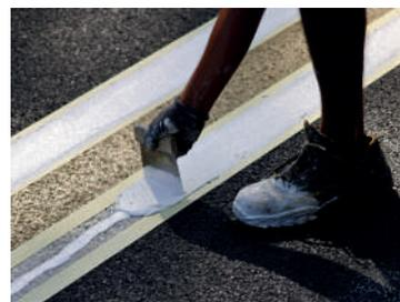
Figure 47 : Application manuelle d'enduit à froid
