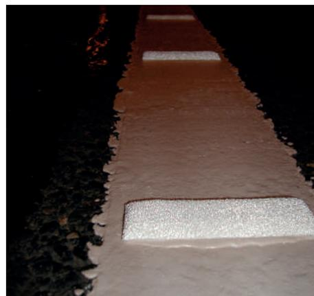
Figure 29 : Exemple de semelles et barrettes préfabriquées
