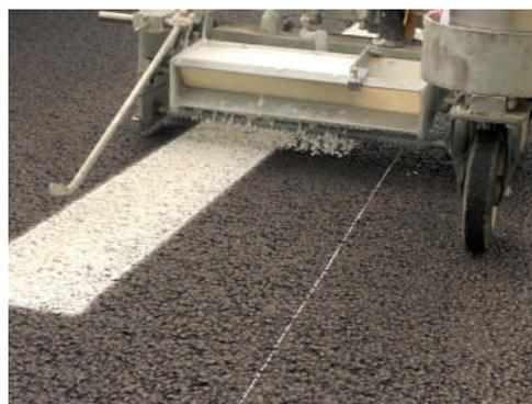
Figure 43 : Application d'enduit à froid en spot ou crépis
