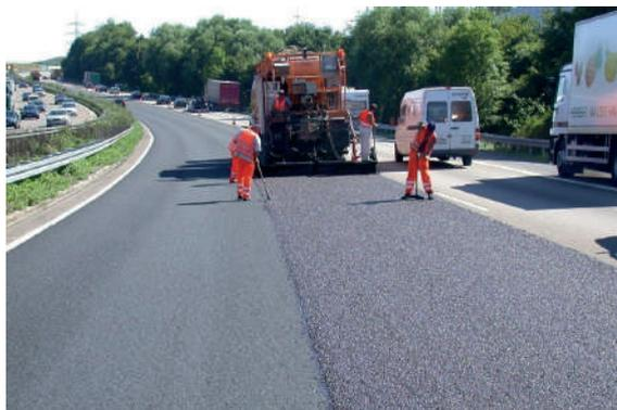
Figure 30 : Application de produits bitumineux
