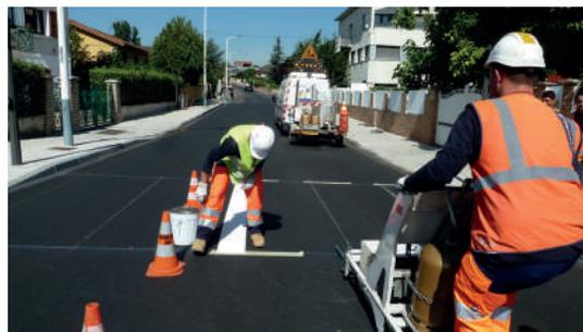
Figure 11 : Illustration de l'application d'enduits à chaud extrudés
