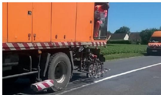
Figure 13 : Exemple d'application d'enduits à chaud projetés
