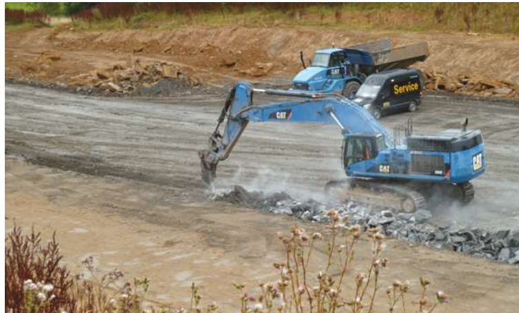
Photographie 13 : Extraction de schistes, quartzophyllades sous forme de bancs à l'aide d'un brise-roche (Source : SCSNE)
