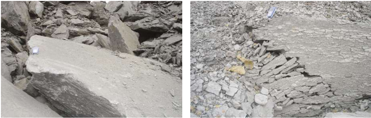
Photographies 7 et 8: Évolution d'une marne en dépôt. Photo de gauche, la marne est en bloc, compacte. Photo de droite, même bloc après évolution « sous sollicitation naturelle » (Source : Eiffage)
