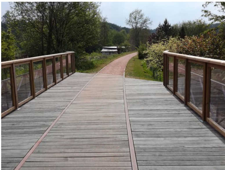
Illustration 12 Réaménagement d'un ouvrage d'art avec conservation des rails
