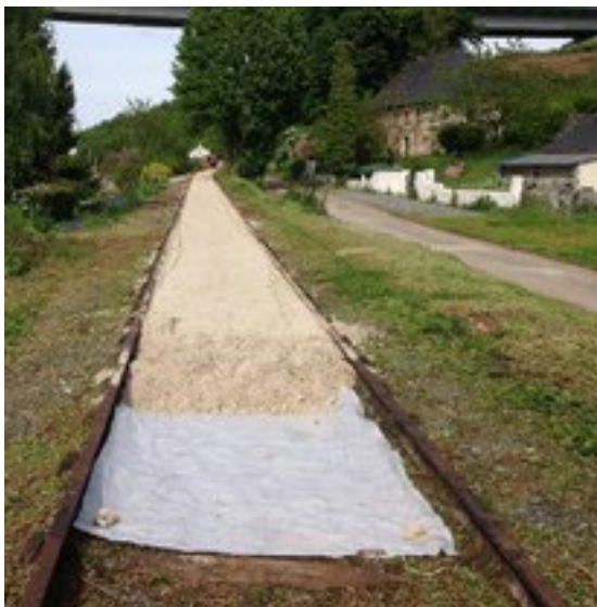
Illustration 7 Les rails et traverses ont été conservés dans le projet
