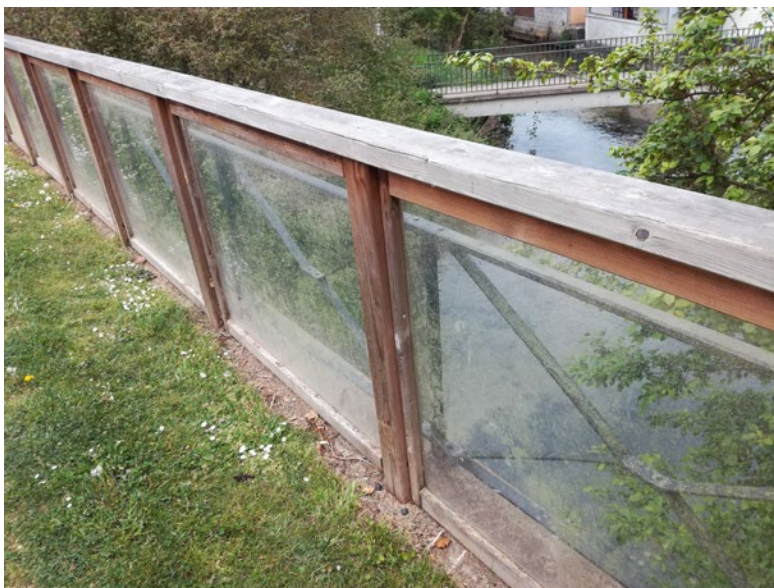
Illustration 11 Des nouveaux garde-corps ont été installés tout en maintenant les plus anciens
