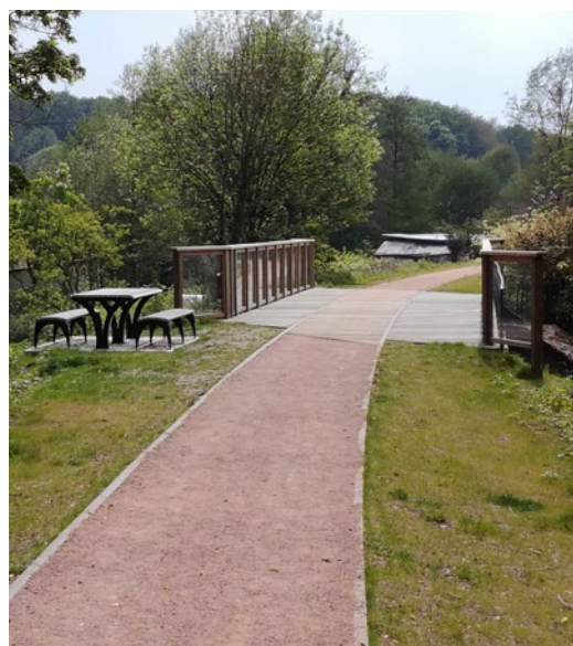
Illustration 14 Mobiliers installés à proximité de la voie Claude Lemesle
