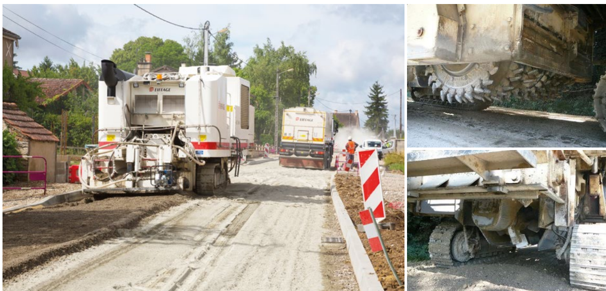
Mise en œuvre du procédé innovant dans le cadre des travaux d'entretien de la traversée de Demigny
