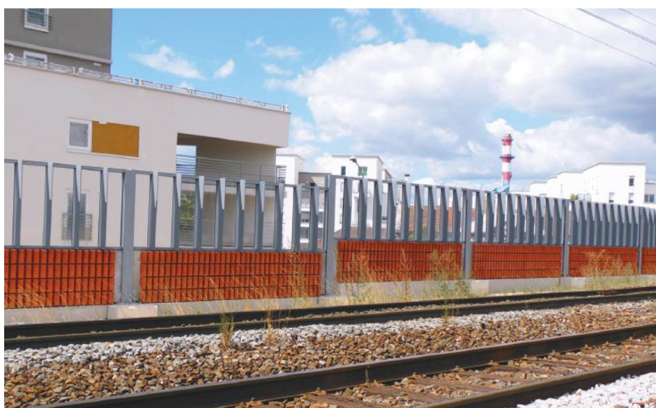
Écran mixte béton de bois / transparent absorbant — Tangentielle Nord — Grand Paris (78, 93, 95)
