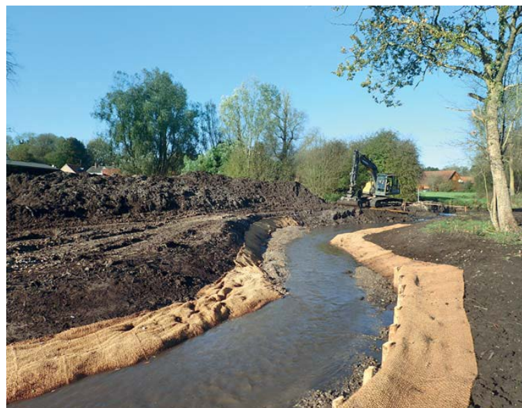
Illustration 7 : Stabilisation des berges avec géotextile coco (80) © SIAHM
