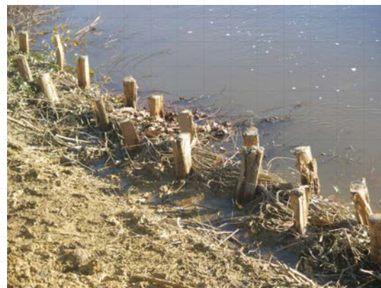
Illustration 9 : Aménagement de fascines sur le Maumont Blanc (19) ©Cerema
