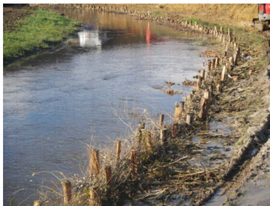
Illustration 8 : Aménagement de fascines sur le Maumont Blanc (19) ©Cerema
