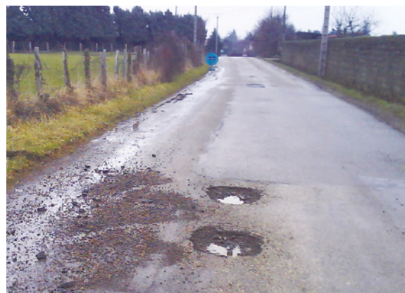
Dégradation de la voie
