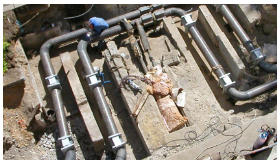
Réseau de transport de distribution de chaleur sous voirie
