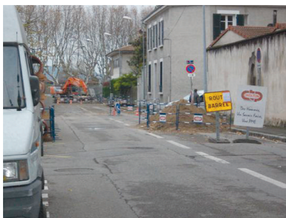
Rue en chantier
