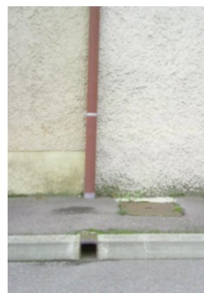
Descente de toiture et extrémité de gargouille
