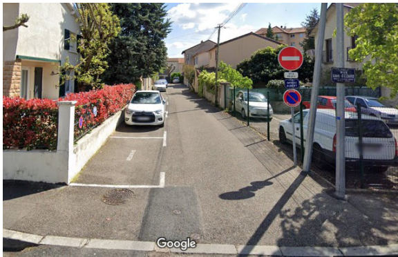
Abaissement de bordure pour raccordement à la voie publique (© Google)
